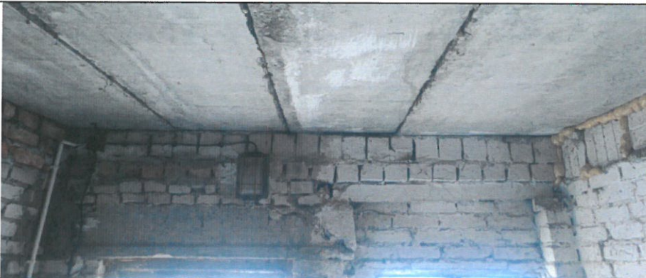
Połączenie ścian z płytami stropodachu – ściana boczna
