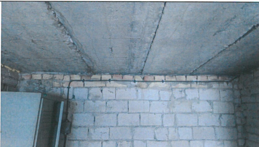
Połączenie ścian z płytami stropodachu – ściana szczytowa
